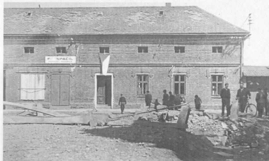
Zbořený most přes náhon řeky Bystřice (pohled od mlýna na obchod u Spáčilů)
