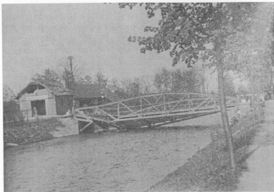
Zbořený most přes řeku Bystřici
