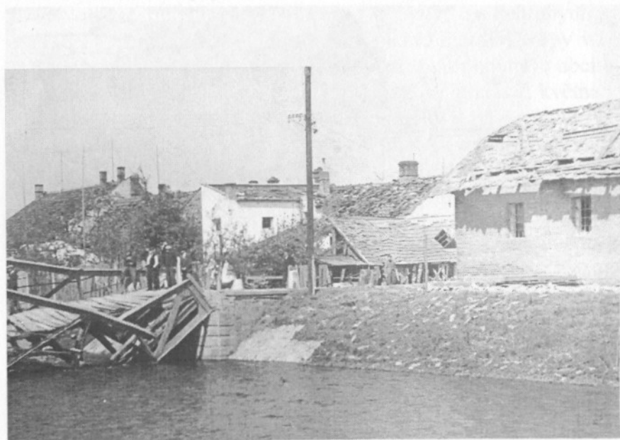
Zbořený most přes řeku Bystřici
